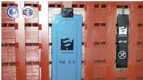
**Sensor VM** - Para el monitoreo del entrehierro, y sensor MFM para la medición del flujo magnético
