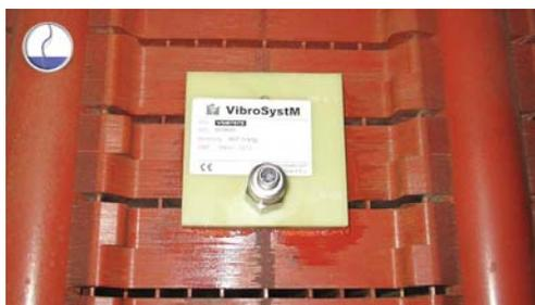
**VSM797S** - Acelerómetro piezoeléctrico para la medición de las vibraciones del núcleo del estator
